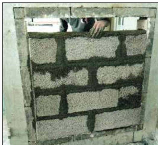
شکل ۳. اجرای دیوار با بلوک های سیمانی لیکا و استفاده از ملات ماسه و سیمان در درز بلوک ها
