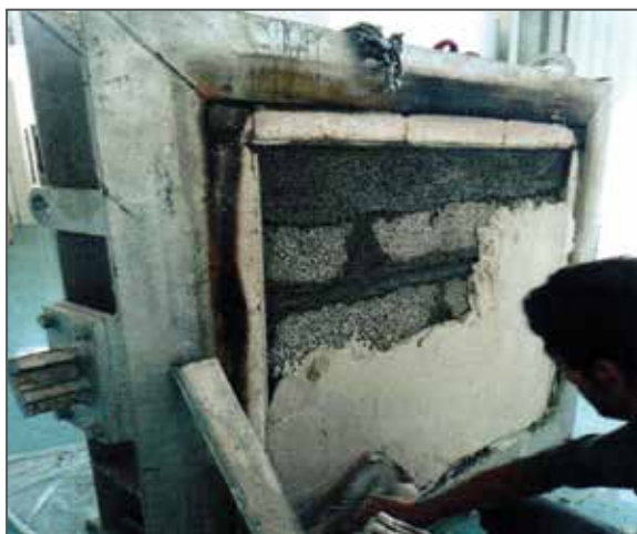
شکل ۴. اجرای اندود گچ به ضخامت ۱/۶ سانتی متر در روی دیوار
