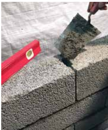
پر کردن درز قائم ملات ریزی در دیوار چینی
