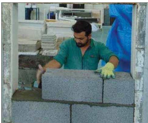
شکل ۲- اجرای دیوار با بلوک های سیمانی لیکا و استفاده از ملات ماسه و سیمان در درز بلوک ها
