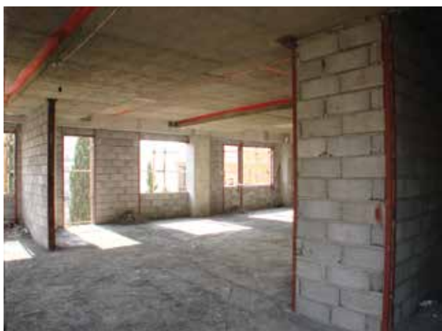
مهاربندی کامل دیوارهای غیر باربر
