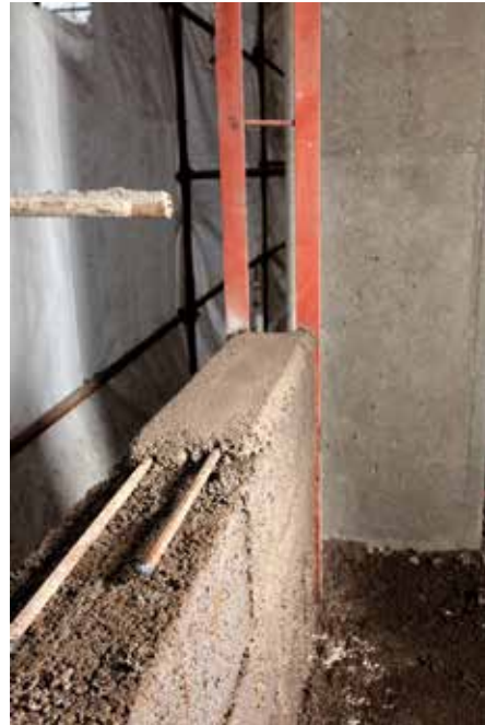
قراردادن میلگرد مهاری در گ ملات
