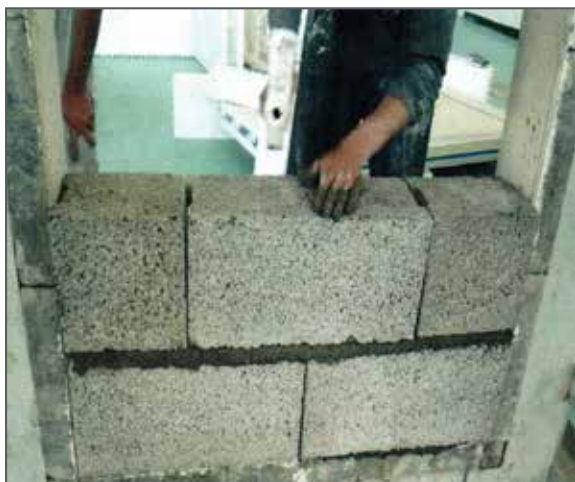
شکل ۲. اجرای دیوار با بلوک های سیمانی لیکا
