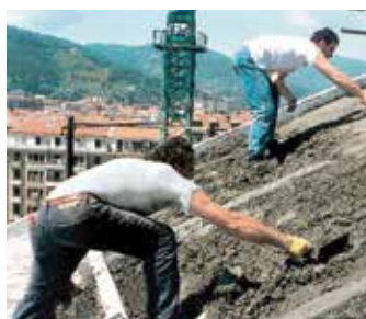
کفسازی با روش بتن سبکدانه
