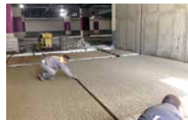
شمشه کشی جهت تسطیح نهائی سطح کفسازی شده با روش دوغاب ریزی
