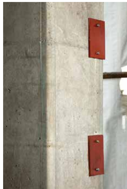
رول بولت کردن پلیت به ستون بتونی جهت اتصال میلگرد مهاری
