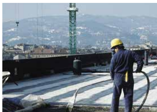
روش کف سبک به وسیله دوغاب ریزی
