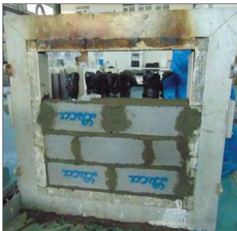
شکل ۲. اجرای دیوار با بلوک‌های سیمانی لیکا و استفاده از ملات ماسه و سیمان در درز بلوک‌ها
