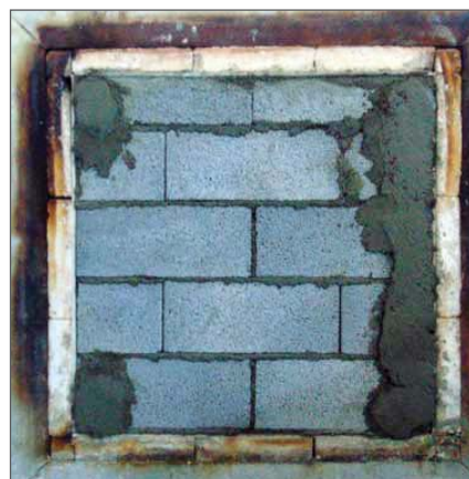
شکل ۳- اجرای ملات ماسه و سیمان به ضخامت ۱ سانتی متر بر روی دیوار
